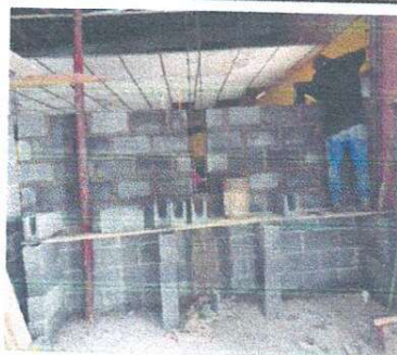
Foto 4: Colocando el block de la división entre Dirección JV y la bodega.
