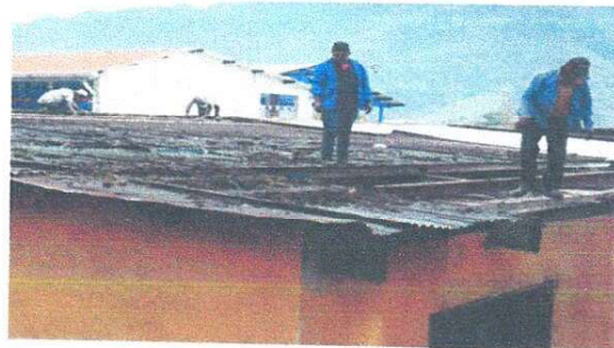
Foto 2: Área a destechar para sustituir las láminas deterioradas: Bodega, Dirección JV y aula de Preprimaria de las dos jornadas.
