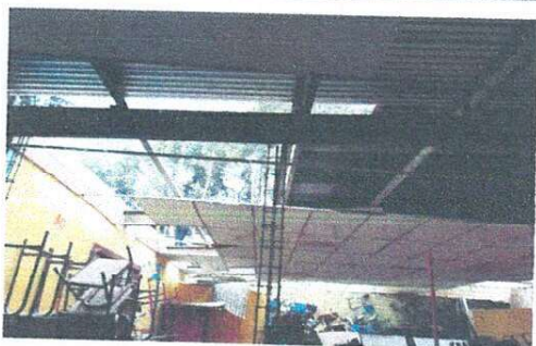
Foto 3: Iniciando el Enlaminado del área que ocupa la bodega.
